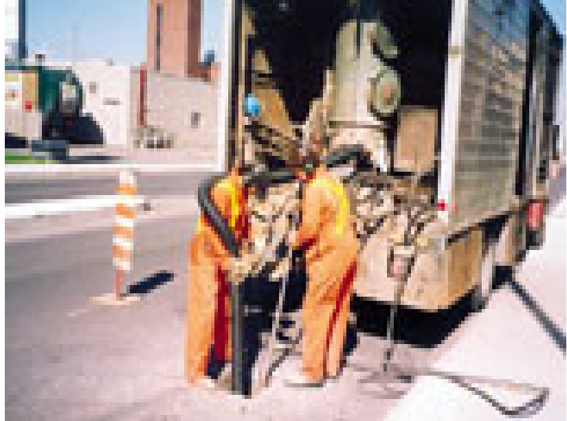
شاحنة مجهزة بألة ضخ الماء تحت ضغط لتنظيف القنوات
